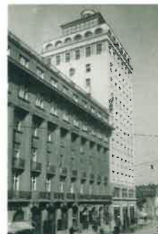
Ljubljanski Nebočičnik arhitekta Vladimirja Šubica, zgrajen leta 1933, je bil takrat najvišja stavba v Kraljevini Jugoslaviji in prva protipotesna gradnja s skeletom iz železobetona.
